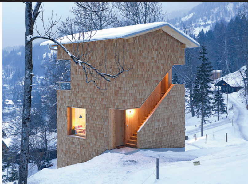
Auf dem Areal um das Hauptgebäude des Hotels und Gesundheitsresorts Tannerhof plante Nagler moderne Holztürme in Brettspertholz-Bauweise mit drei Einheiten übereinander
