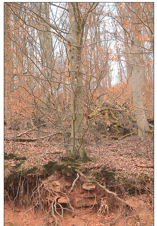
Bäume an oder auf Hangkanten müssen entnommen werden. Durch ihre Hebelwirkung bei Wind kann ihr Wurzelwerk Steine an der Abbruchkante lockern und so zum Steinschlag beitragen bzw. Bodenerosion auslösen.
